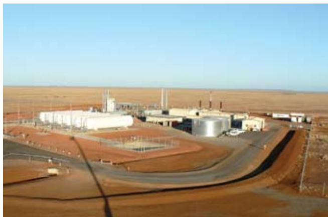
LNG Plant in Karratha
